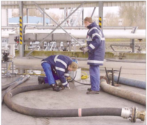
Schlauchprüfung durch „befähigte Personen“ mit Wasser und dem 1,5-fachen Betriebsdruck
