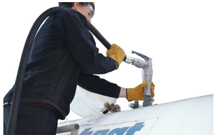
Bild 1: Befüllung von stationären LPG-Tnks mit GG10
